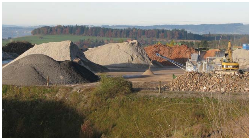
Aufbereitungsanlage mit Lagerplatz für mineralische Bauabfälle.
