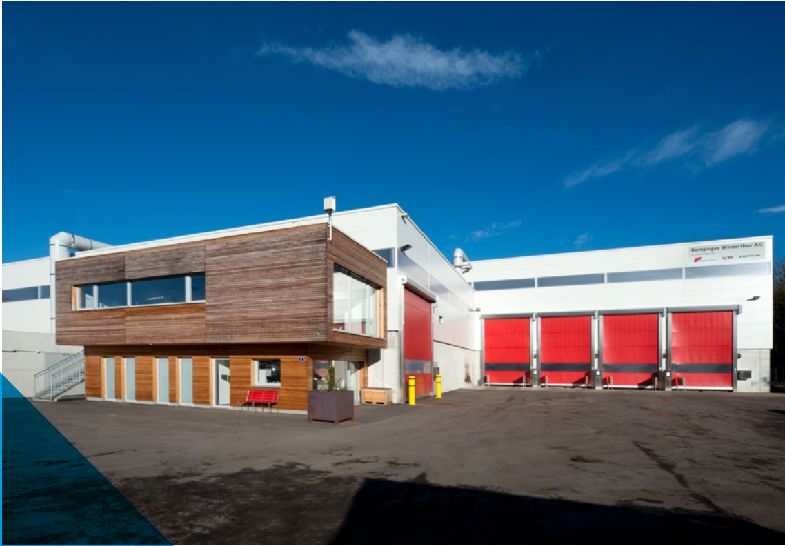
Die neue Anlage von Kompogas in Winterthur.
