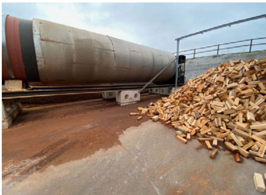
Foto 8: Die Abwärme aus den Biogasanlagen möglichst vollständig zu nutzen ist eine aktuelle Aufgabe. Stückholz Trocknung hier am Beispiel «Topholz» kann als mögliche Abwärmenutzung im Fall von andern fehlenden Abnehmern eine Lösung bieten.
