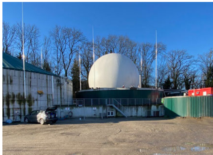
Foto 3: Die landwirtschaftlichen Biogasanlagen bestehen zunehmend aus grossen Behältern, auch weil sie für 5 Monate Lagerkapazität sicherstellen müssen.
