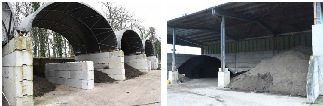
Exemple de stockage du compost pour le protéger des intempéries
